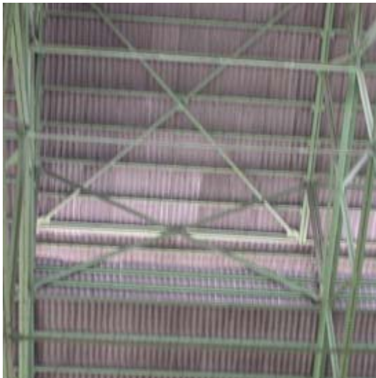
6、其他钢构件：钢支撑、钢檩条、钢墙架
