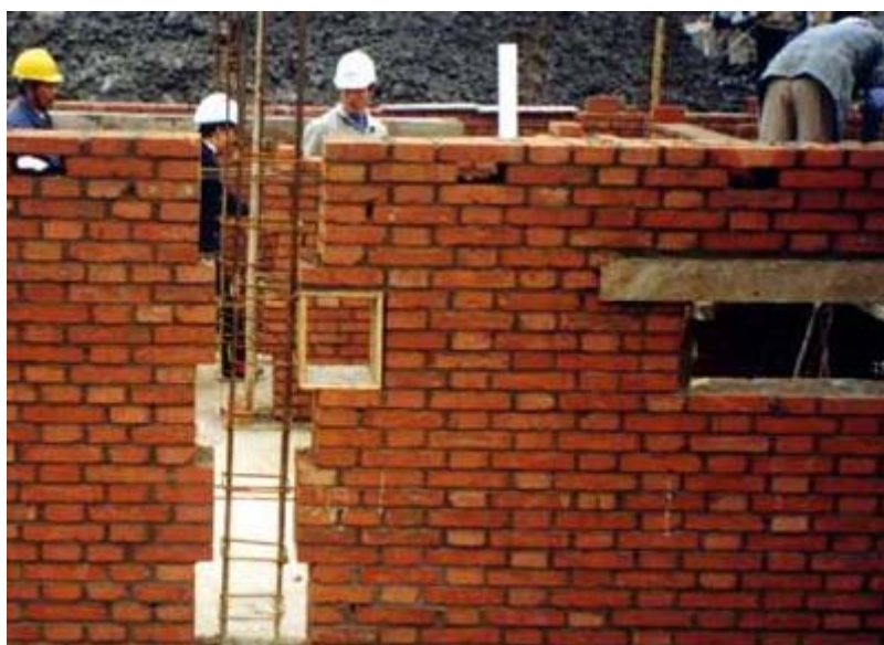
图 2.3.12 构造柱、圈梁
