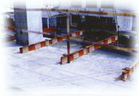
悬挑杆件固定
