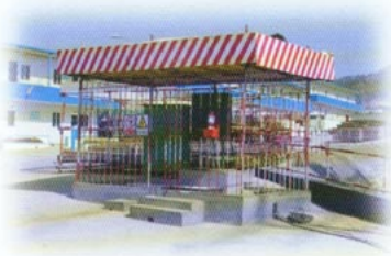
总、分配电箱防护棚
