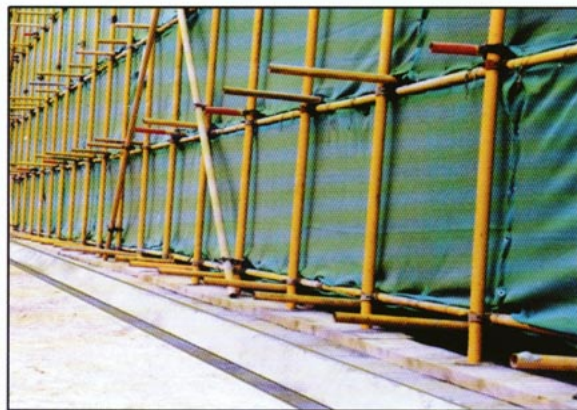
立杆基础、排水沟
