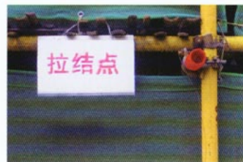
脚手架杆件拉结点标志
