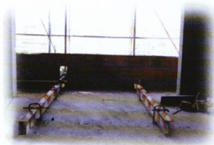
悬挑杆件固定
