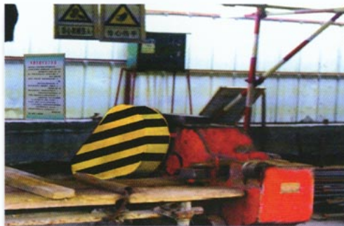
钢筋切断机防护
