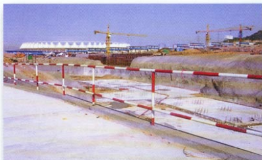
基坑临边防护
