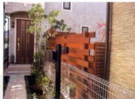
④ 栅栏的板块交错出空隙，有利于通风。阳光也能照射进来。
