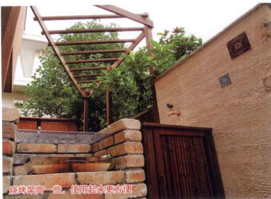
④ 烧烤炉安装在一个较宽敞的台阶上，为了能在甲板上烧烤，特意设计得高些。
