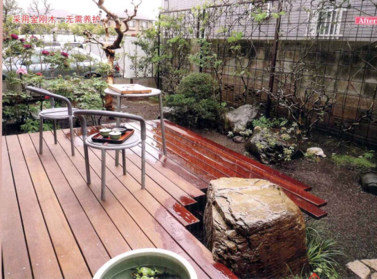
改造后庭院整体景观。因为采用金刚木素材的甲板，免除了今后养护的担忧。
