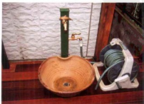
为了防止软管的接口处滑落，事先安上浇水用的水龙头就很便利了。
