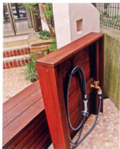
① 金剛木长凳装饰的立水栓遮挡了浇水用的水龙头和橡皮管。
