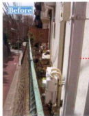
❶ 改造前宽 1.2 m 左右的庭院，只有混凝土铺成的长形走廊。
