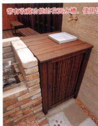
⑤ 用金刚木甲板和人工竹为花园水槽搭建了一个门扉。在水槽里有浇水的皮管和水龙头。考虑到美观，通常把不太雅观的管子收起来，这里还可以存放一些小东西。左图为门扉关闭的状态。右图为门扉敞开的状态。
