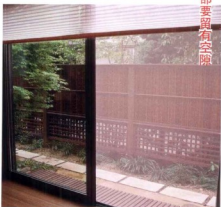
⑦ 使用人工竹，修建原始栅栏。栅栏上部需要遮挡外来视线，下部考虑了通风作用，选择种些杂草。
