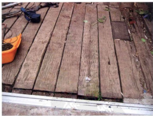
④ 改造后的枕木铺得很平整。剩下的用在停车场的修建上。
