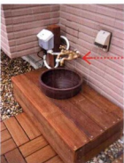
④ 壁泉有两个水龙头，分别用于自动浇水和洗手用。自动浇水（左）是电池式的。靠定时而来工作。
