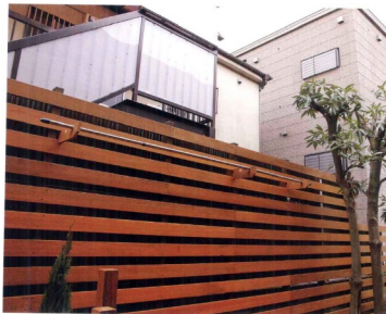
⑦ 装卸式的晾晒设施。安装后的状态。为了充分利用缝隙宽度一致的栅栏，可以在自己喜欢的高度上安装上晾晒设施。
