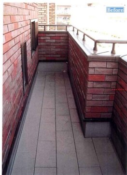
① 施工前的状态。
