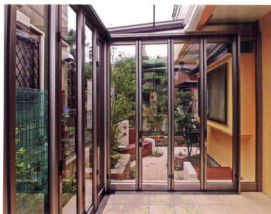
② 日光室整体采用推拉式玻璃框架。
