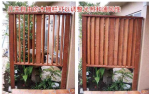
木栅栏的立板，打开的状态（左）和关闭的状态（右）。
