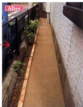
❶ 改造后，用细沙铺装材料处理，看起来又干净，又整洁。然后用砖砌出边沿，让藤蔓植物缠绕栅栏。
