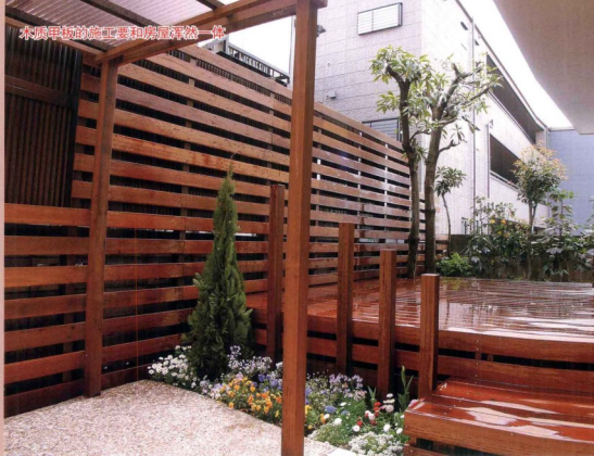
④ 改造后的场景。由于建筑物地基较高，木质甲板的修建为了与建筑物高度相适应，甲板高度也相应抬高。
