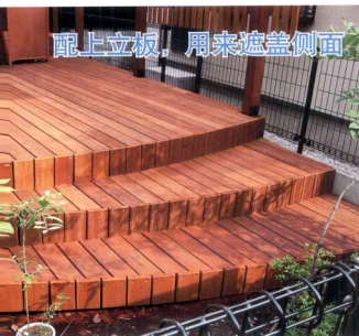
④ 有可以遮阳的西式藤架。保护底部的下部和绿化空间。是一个功能较齐全的木质甲板。素材采用的是无需养护的金刚木。
