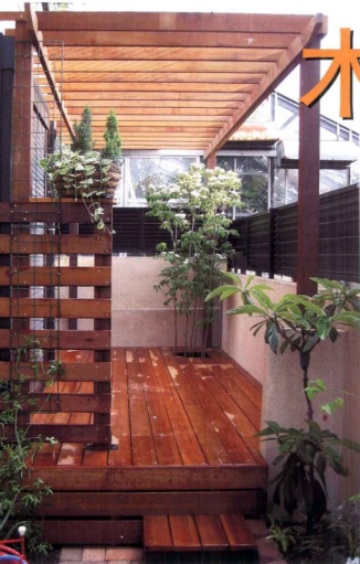
④ 有可以遮阳的西式藤架。保护底部的下部和绿化空间。是一个功能较齐全的木质甲板。素材采用的是无需养护的金刚木。
