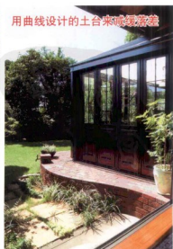
④ 从起居室观望日光室的侧面。土台的砖瓦采用曲线设计，减缓了落差感。
